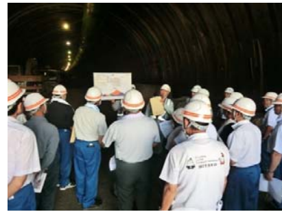
(仮)新箱石トンネル工事現場
